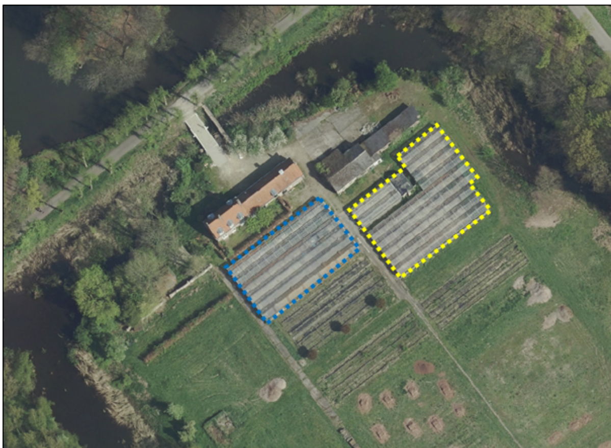
Overzicht te slopen bebouwing
