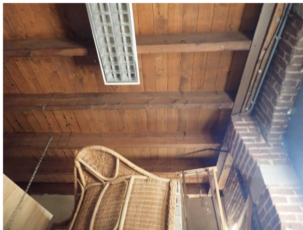
Foto 8: rechts, een van de bergruimten aan de zuidzijde van de bosschuur. De planken vormen de vloer van de verdieping.
