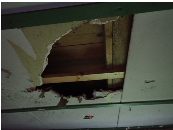
Foto 7: links, constructie van het plafond in de keuken en toiletgroep.
