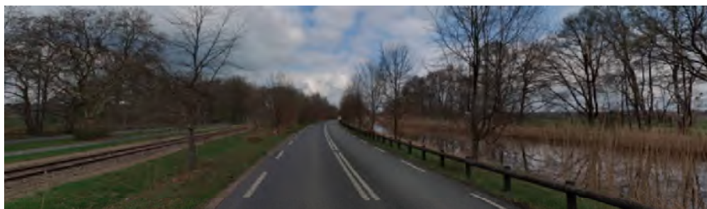
Figuur 3-1 Wegbeeld Kanaalweg/N786 (in beheer provincie Gelderland)
