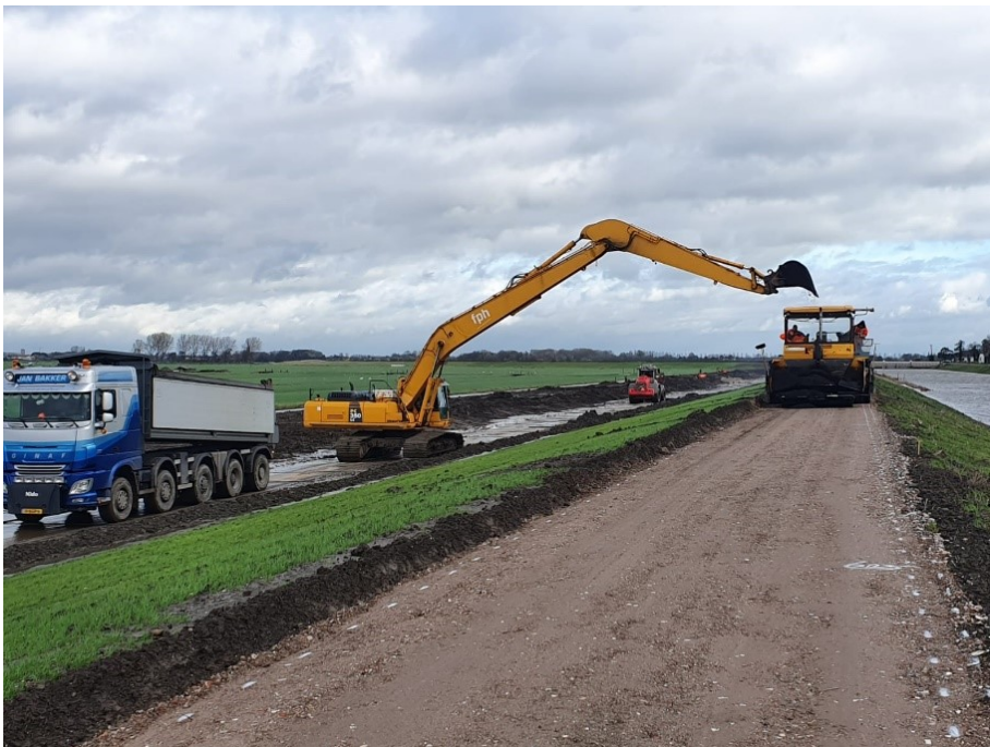
Asfalteren fietspad langs de Limietsloot
