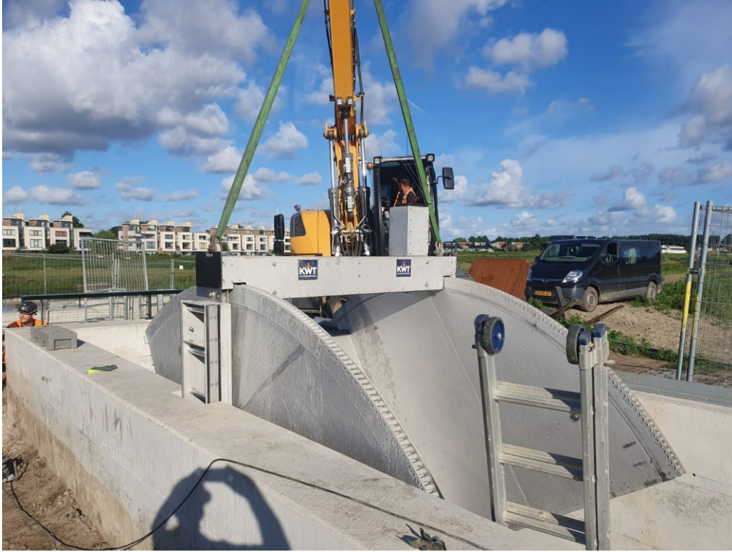
Inhijsen van de aflatstuw van de piekberging
