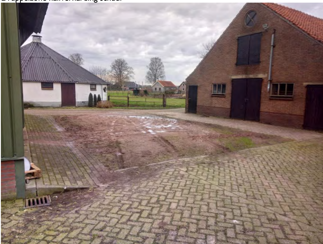
Druppelzone halfverharding schuur
