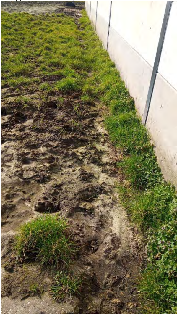
Druppelzone oostelijke schuur
