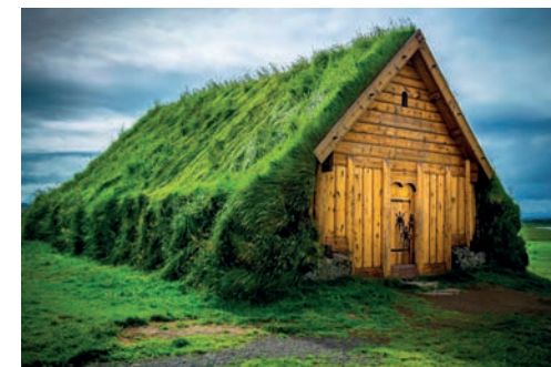
Oervorm van groendak en groengevel- Scandinavische schuur waarbij door isolerende werking van het gras het binnenklimaat jaar rond gelijkmatig is.
