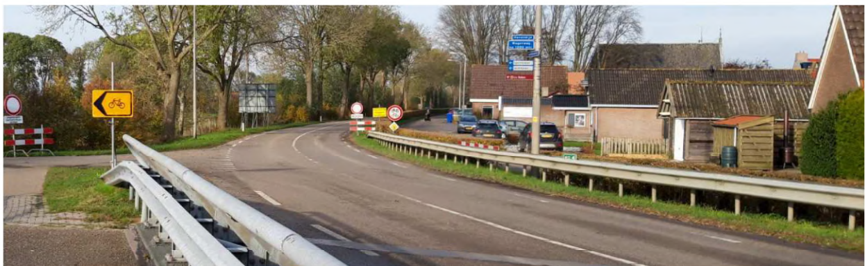
Foto: aansluiting Havendijk met metalen geleiderails
