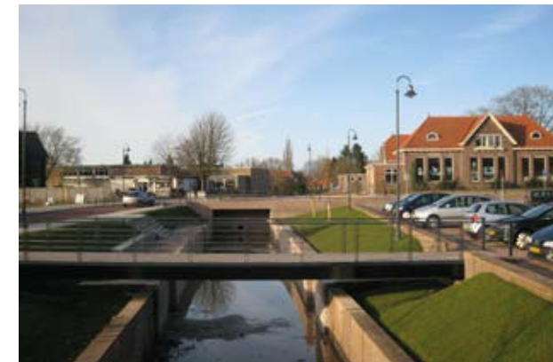
Oude sluis aan de Paardenmarkt
