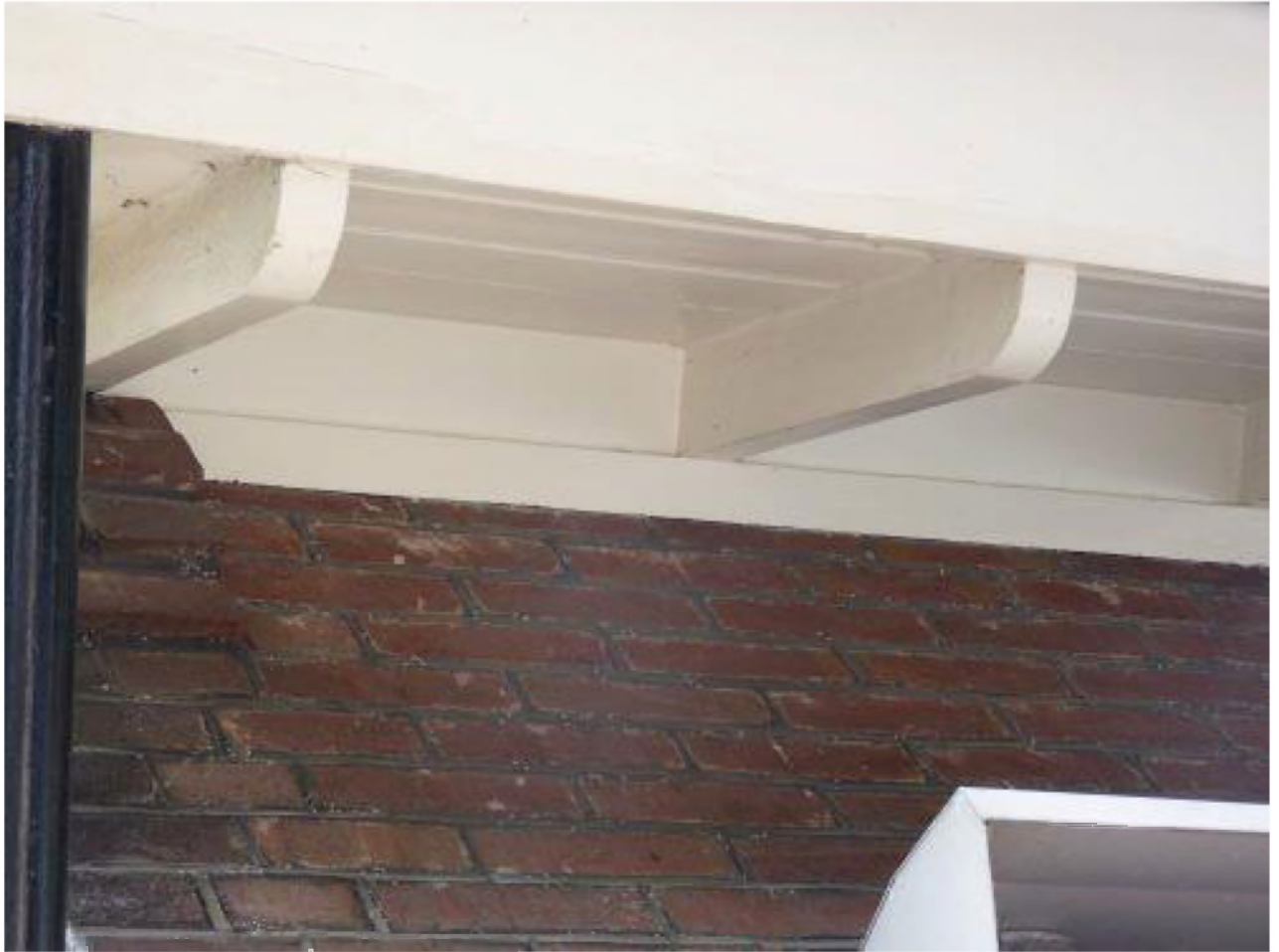
Detail van de dakrand aan de achterzijde van het hoofgebouw
