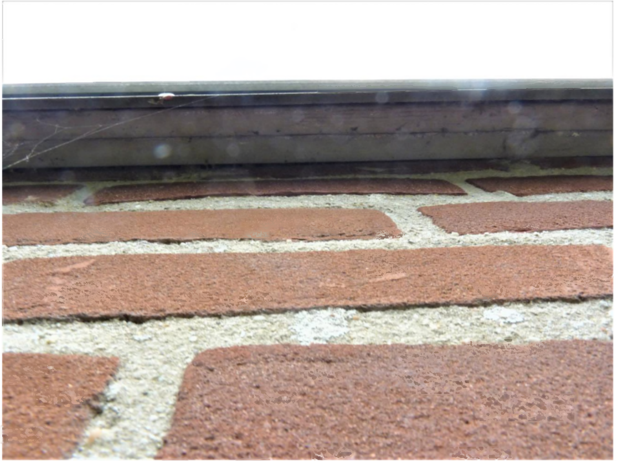
Dakrand zonder openingen
