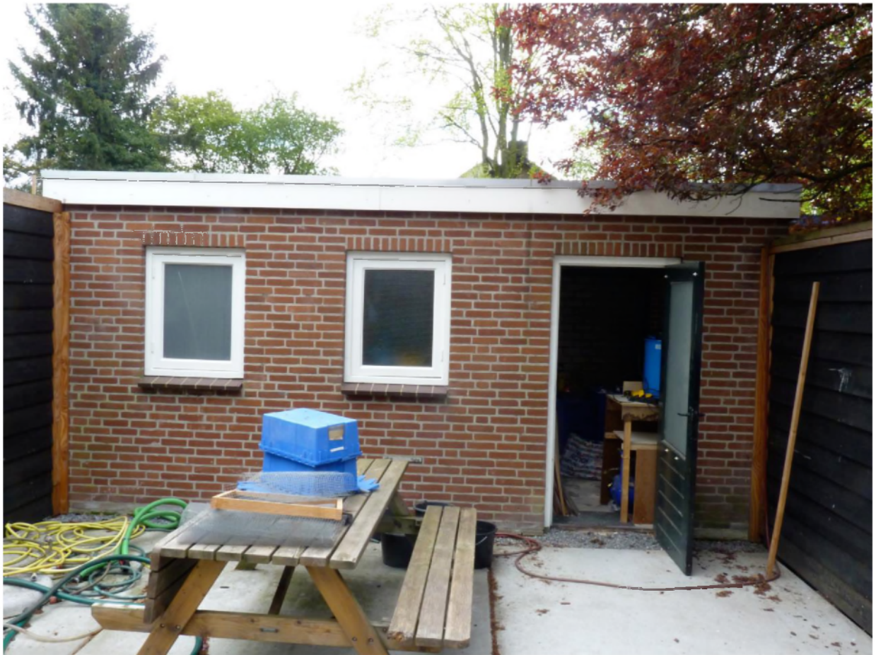
Bijgebouw 2 heeft een spouwmuur
