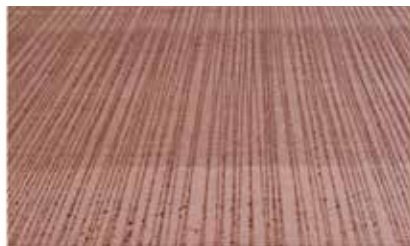
Busbaan De busbaan wordt uitgevoerd in standaard roodgekleurd beton dat aansluit op het vervolg van de busbaan.
