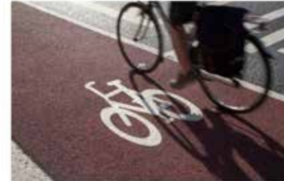
Fietspad Het fietspad wordt uitgevoerd in rood asfalt.
