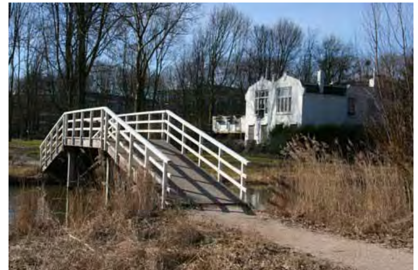
Referentiebeeld van bestaande brug over nevengeul van de Kromme Rijn
