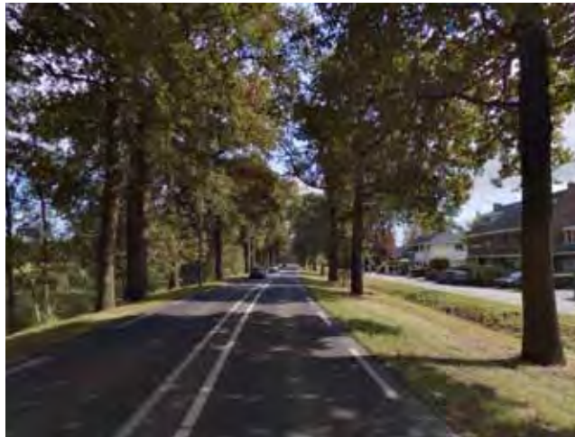
Bestaande situatie Koningslaan in buitengebied
