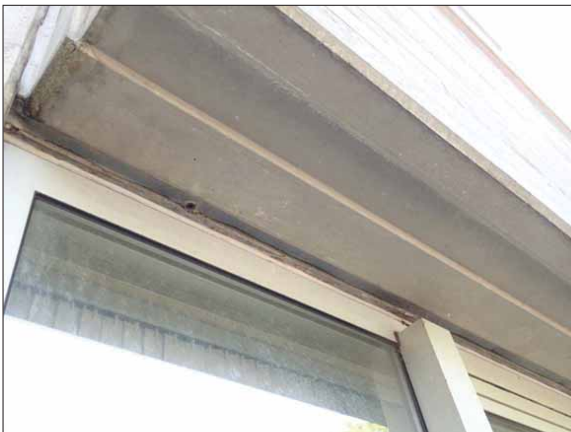
Foto 5: Met kit afgesloten kieren
