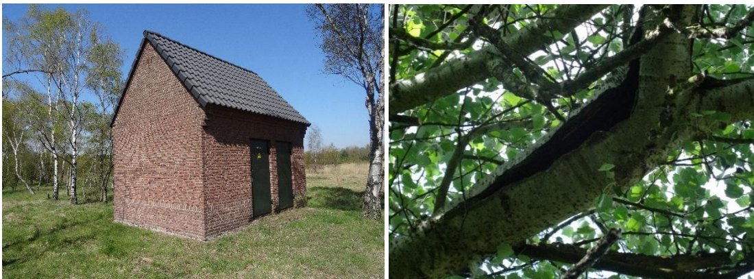
Figuur 4.1: Elektriciteitshuisje en boomholte in plangebied. Sweco mei 2015
