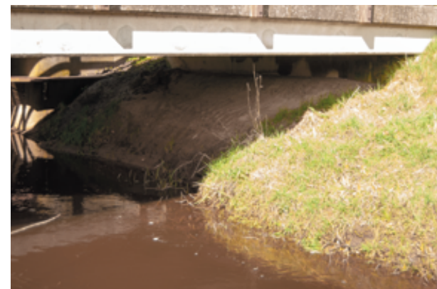
Afb. 2.13 Huidige oever onder fietspad Sterkselse Aa
