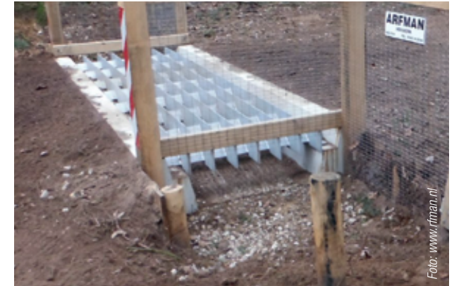
Afb. 3.8 Voorbeeld rooster voor zijwegen: wildrooster speciaal geschikt voor dassen
