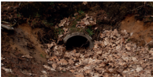
Afb. 2.18 Een van de aangebrachte faunabuizen in Someren
