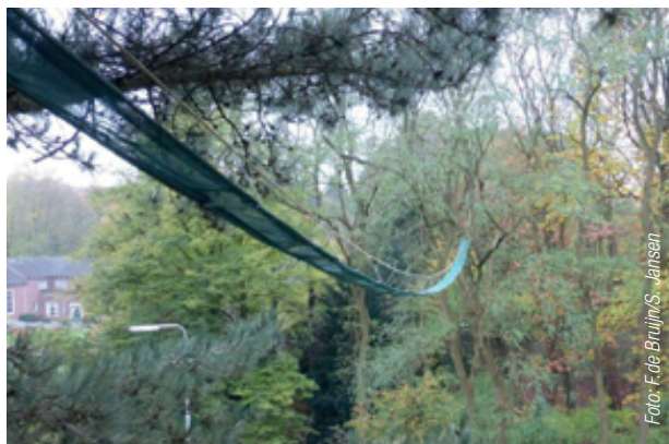
Afb. 3.18 Onderaanzicht boombrug in Roermond
