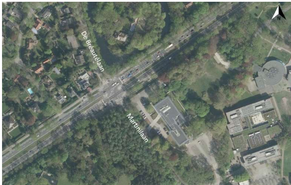
Figuur 2.5. Luchtfoto kruising Martinilaan/De Bréautélaan
