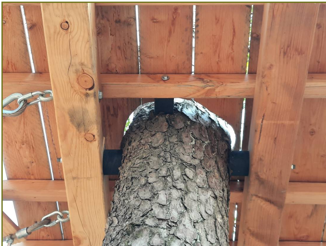
Afbeelding 11. Bevestiging plateau geheel doorboord
