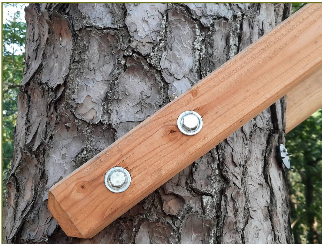
Afbeelding 12. Bevestiging ondersteuning plateau enkel geboord
