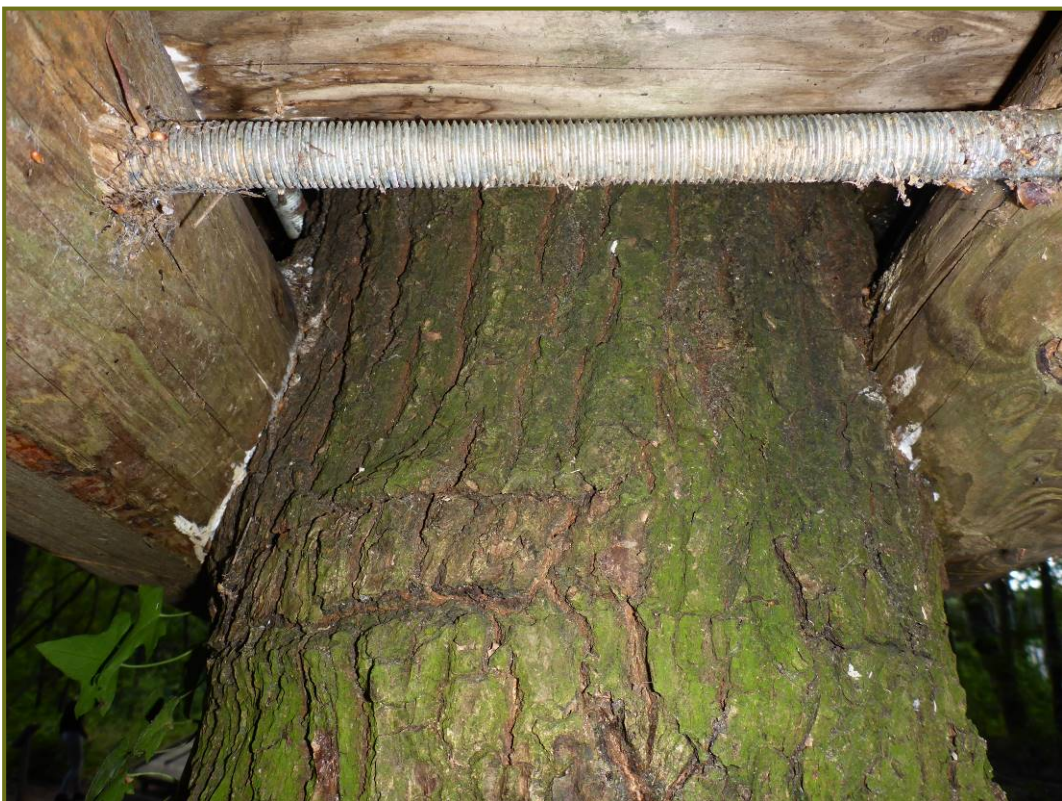
Afbeelding 17. Vastklemmen van onderdelen aan de stam. Ernstige vergroeiingen binnen 5 jaar. Voorbeeld uit een ander klimbos in Nederland.
