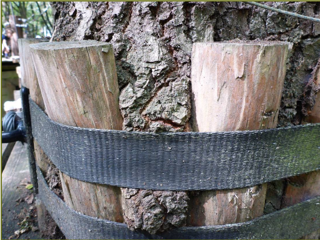
Afbeelding 16. Vastklemmen van onderdelen aan de stam. Ernstige vergroeiingen binnen 5 jaar. Voorbeeld uit een ander klimbos in Nederland.
