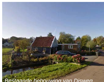
Bestaande bebouwing van Disweg
