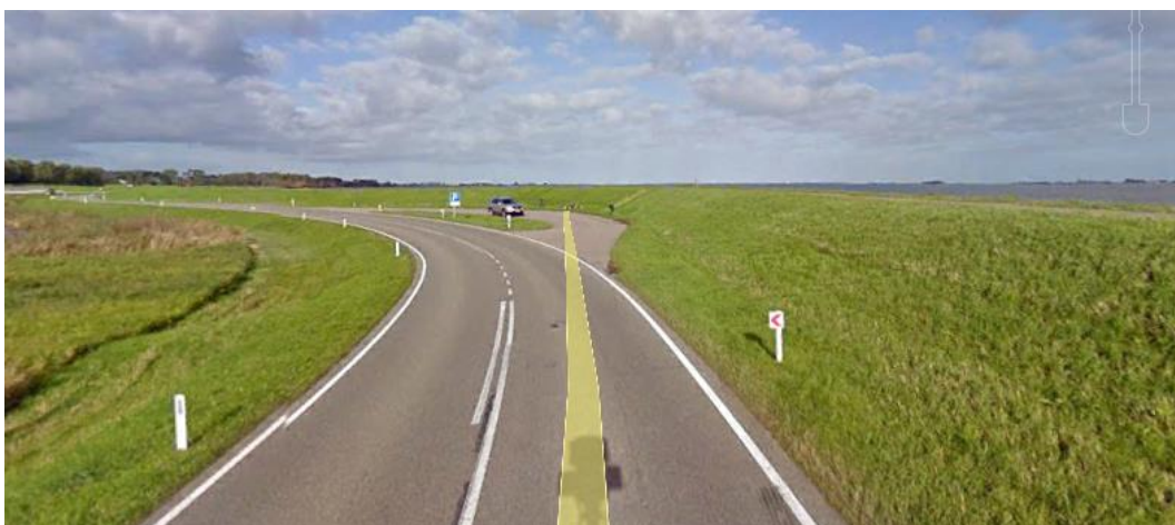
Figuur 5: Bestaande situatie aan de binnenzijde van de dijk
