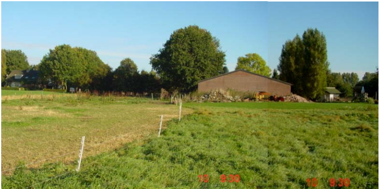
Foto 5: Compositiefoto gezicht op achterzijde verlaten varkensschuur aan de overzijde van het woonhuis aan de Eindsestraat 20 te Nederasselt/Balgoij (Gemeente Heumen) richting noorden.
