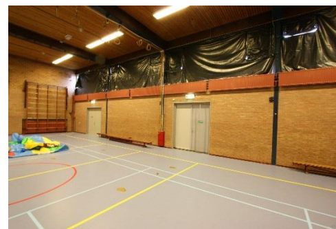
Gymzaal De Zandloper: geblindeerde ramen.
