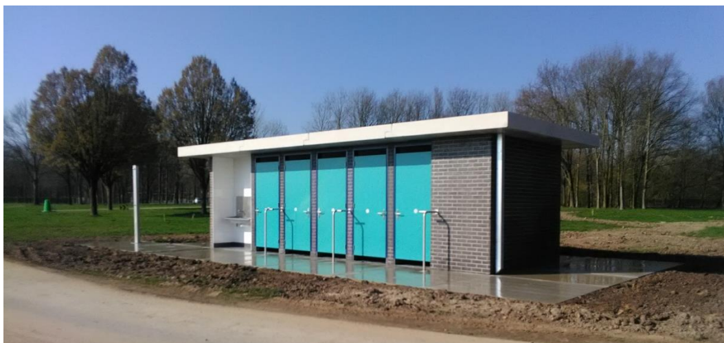
Figuur 13: Foto nieuwe toiletgebouw
