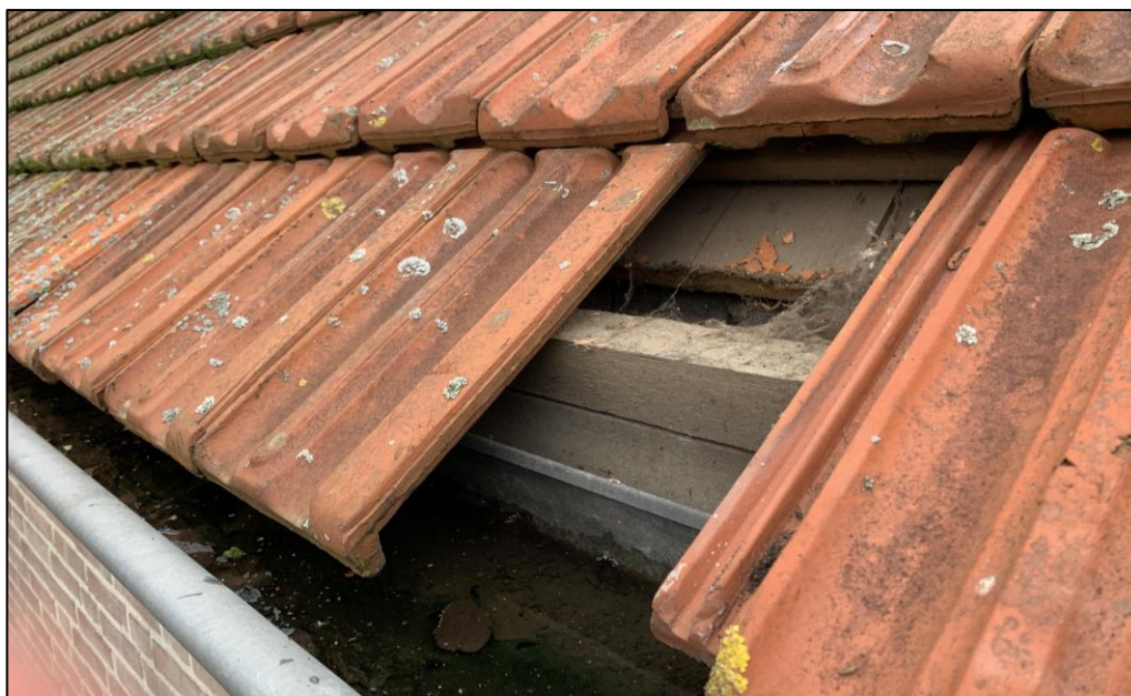
Figuur 5 De dakpannen zijn geplaatst op een plank waardoor er geen toegang is voor de huismus.
