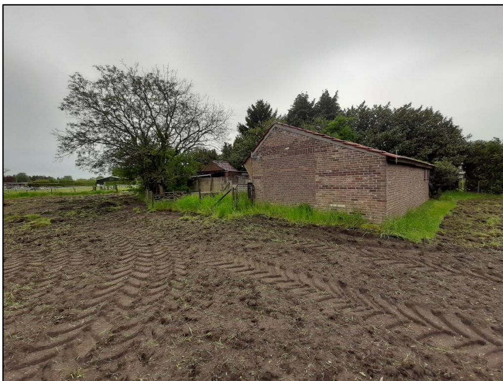
Figuur 2 De bebouwing op de planlocatie gezien vanuit het noordoosten.
