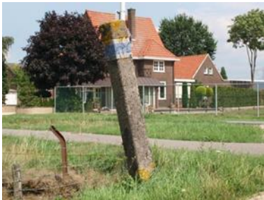
Deze paal staat langs de Graafseweg op de hoek van de Rijdtsestraat.
