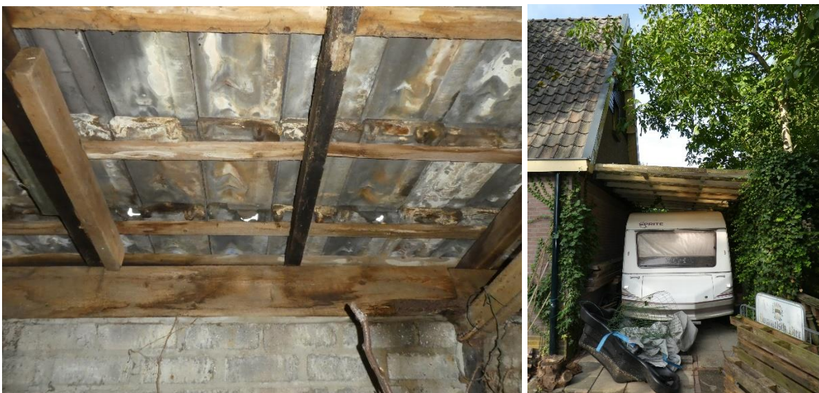
Afbeelding 9 en 10: geen mogelijke nestlocaties van de huismus in de te slopen bijgebouwen. Bron: BNL advies, datum: 07-09-2022
