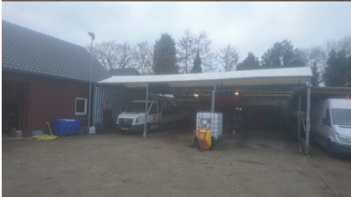
De hoofdgebouwen op het perceel (loods en overkapping).
