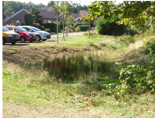
Vitens heeft in samenwerking met de gemeente een systeem ontwikkelt om het hemelwater zonder riool op een natuurlijke manier af te voeren.
