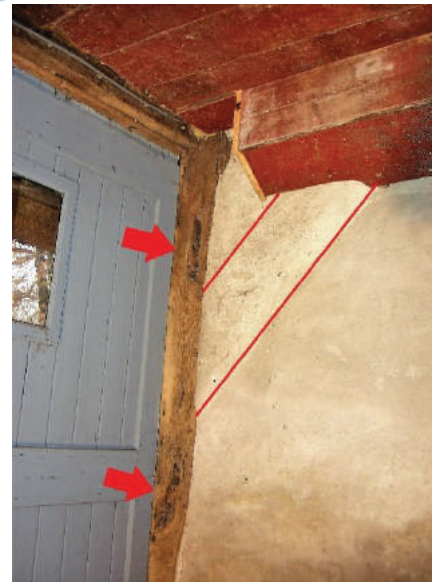
93 – 94. De pengaten van verwijderde jaagbanden en een hildebalk laten zien dat zich op de plaats van de baander ooit een gewoon gebintvak bevond. Achter de pleisterlaag van de brandmuur zit een korbbeel verstopt (rode lijnen)
