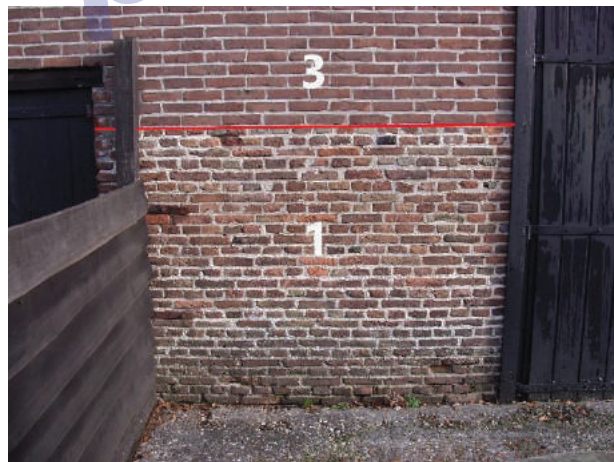
42 - 44. Bouwfaserings in de achtergevel: 1: handvormsteen 22 x 11 x 4/5 cm, steens muur. 2: vormbaksteen 21 x 10 x 5 cm, steens muur. 3: vormbaksteen 21 x 10 x 5,5 cm, halfsteens muur. 4: dichtgezet / verkleind venster. 5: hoekinzet zuidelijke zijgevel.
