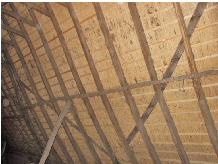
106. Eiken windverband (schuine planken) en gording (horizontaal).
