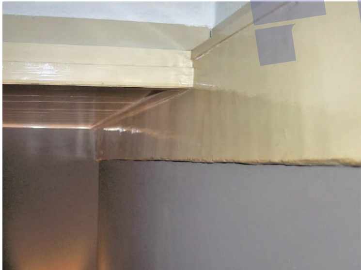
58. Geschilderde eiken ankerbalk boven de brandmuur.
