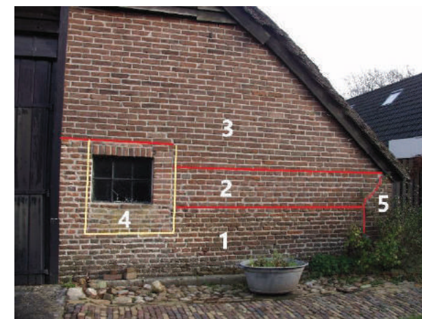
42 - 44. Bouwfaserings in de achtergevel: 1: handvormsteen 22 x 11 x 4/5 cm, steens muur. 2: vormbaksteen 21 x 10 x 5 cm, steens muur. 3: vormbaksteen 21 x 10 x 5,5 cm, halfsteens muur. 4: dichtgezet / verkleind venster. 5: hoekinzet zuidelijke zijgevel.
