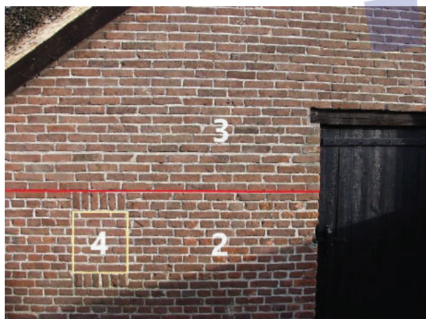
42 - 44. Bouwfaserings in de achtergevel: 1: handvormsteen 22 x 11 x 4/5 cm, steens muur. 2: vormbaksteen 21 x 10 x 5 cm, steens muur. 3: vormbaksteen 21 x 10 x 5,5 cm, halfsteens muur. 4: dichtgezet / verkleind venster. 5: hoekinzet zuidelijke zijgevel.
