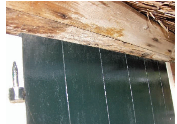
48. Muurplaat annex vakwerkregel.
