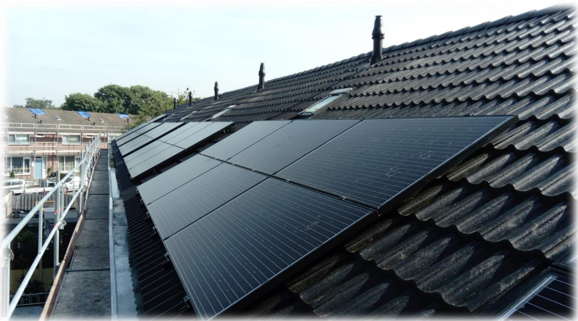
Renovatie 45 woningen Kamerlingh Onnesstraat, Huijgensstraat en Keesomstraat
