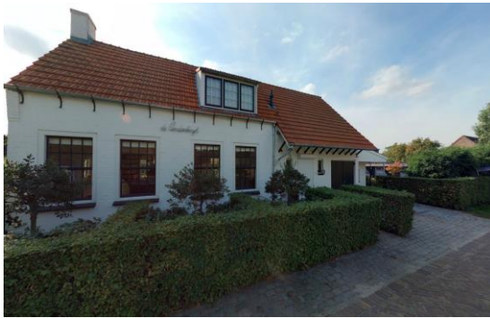
Bestaande woning Valkestraat 1
