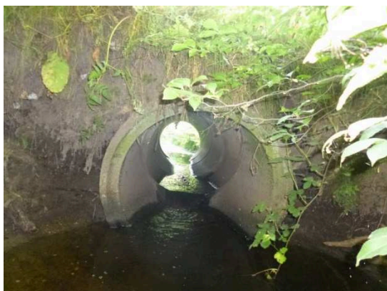
Figuren 2.5 en 2.6: Deformatie van duiker 149-1 Twaalf Weendreef/Armendreef te Putte en plafondschade aan brug 139-8, Langeweg te Ossendrecht
