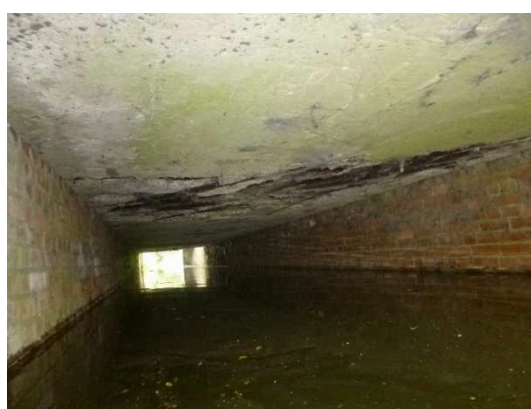
Figuren 2.5 en 2.6: Deformatie van duiker 149-1 Twaalf Weendreef/Armendreef te Putte en plafondschade aan brug 139-8, Langeweg te Ossendrecht
