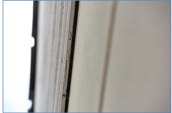
Gevelbetimmering (Bergsestraat) biedt mogelijkheden tot vleermuisverblijven
