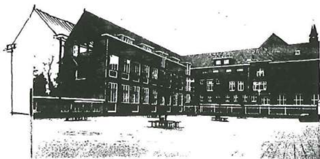
TE VERVANGEN AANBOUW
