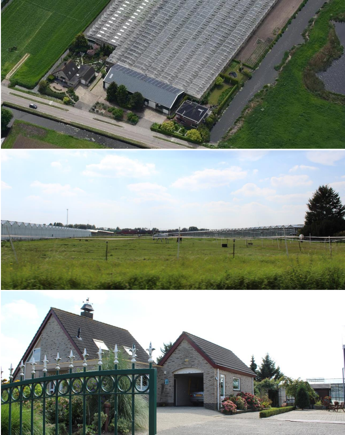
Figuur 1.2 Plangebied huidige situatie te slopen kassen en te behouden bedrijfswoningen
