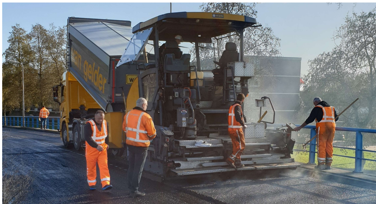
Afbeelding 4. Uitvoering van asfalteringswerkzaamheden.
