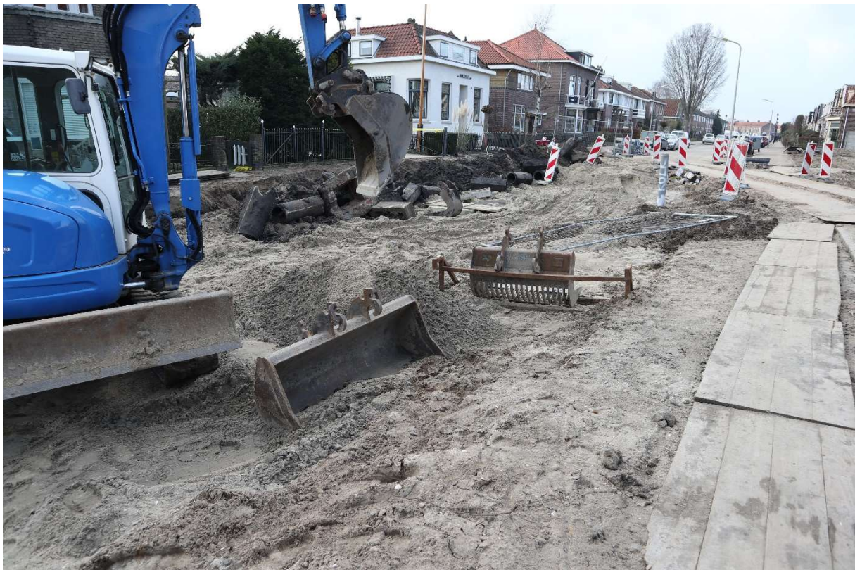
Afbeelding 3. Een voorbeeld van vervanging is een volledige reconstructie van een weg. In dit geval inclusief riolering en groen.
