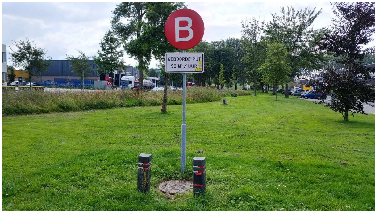
Afbeelding 11. Brandput op industrieterrein de Geer.
