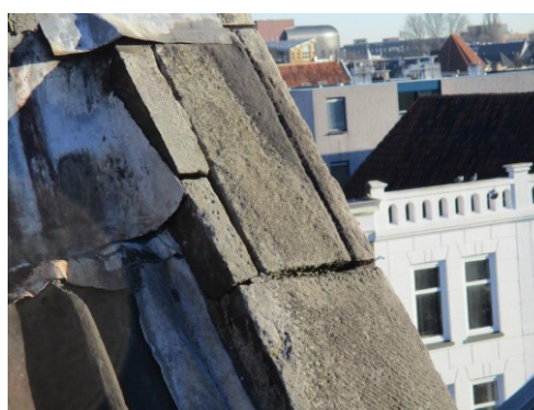
In slechte staat verkerende aansluitingen ter plaatse van de topgevels
