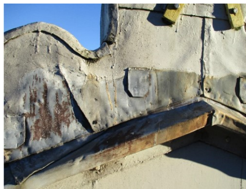
In slechte staat verkerende aansluitingen ter plaatse van de topgevels
