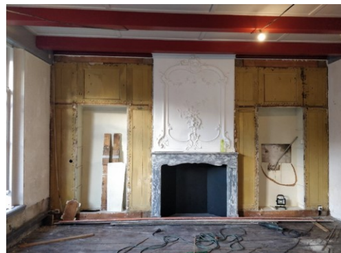
Achter de gedemonteerde binnenaafwerking/bekleding de "gevonden" kastenwand in de ruimte op de begane grond en de eerste verdieping.
