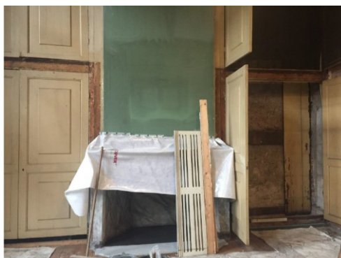
Achter de gedemonteerde binnenaafwerking/bekleding de "gevonden" kastenwand in de ruimte op de begane grond en de eerste verdieping.
