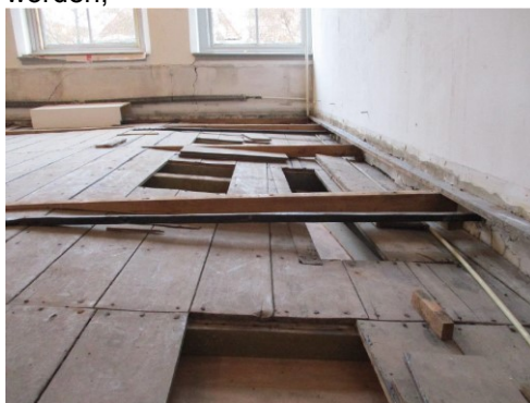
Aflopende vloer, zichtbaar na demontage bovenvloer (zie schegstukken)
