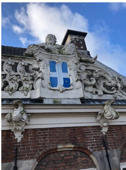
Overzicht attiek en ornamenten/ consoles gootconstructie
