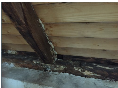
Door zwam aangetaste muurplaat, sporen en dakbeschot.
