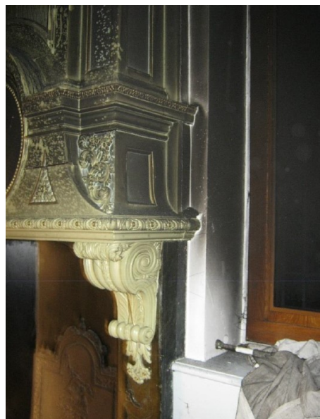
Rechterzijde van de schouw is intact gebleven en dient als voorbeeld voor het nieuwe linkerdeel
