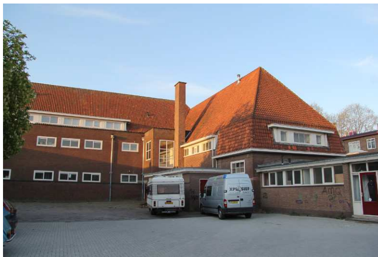
Figuur 4. Achterzijde terrein Hobbemastraat 6.
