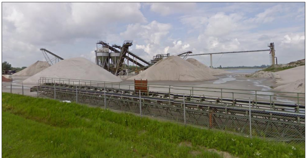
Figuur 4. Aanzicht verwerking zand.
