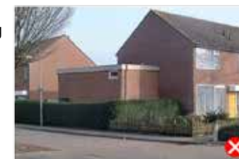
zijaanbouw te hoog
